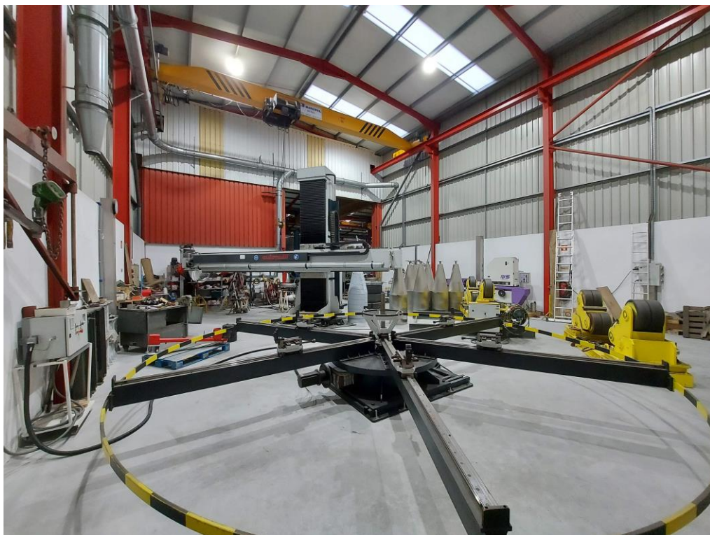
Novo pavilhão para secção de polimento Máquina de Polir tanques e fundos com sistema de despoeiramento Ponte Rolante de Capacidade 10 Tons
